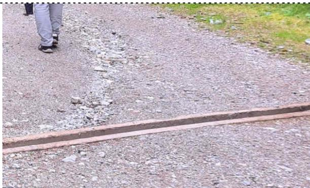
Der Bodenbelag soll zumindest für eine Mindestfahr- und Mindestgehspur glatt, rutschfest und nur mit geringen Fugen ausgeführt werden, um den Anforderungen von Rollstuhlfahrern und auch älteren Menschen (Stolpergefahr) zu entsprechen.
