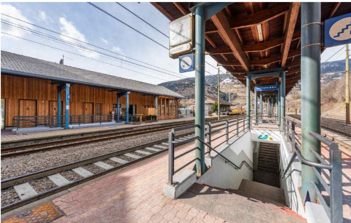
*Bild: Bahnhof Sterzing/Pfitsch - Architektonische Barrieren - Nur ein Treppenzugang, ausstehende Bodenerhöhung für barrierefreien Ein- und Ausstieg in den Zug, fehlender Aufzug, kein Treppenlift, fehlendes taktiles und optisches Bodenleitsystem, ...*
