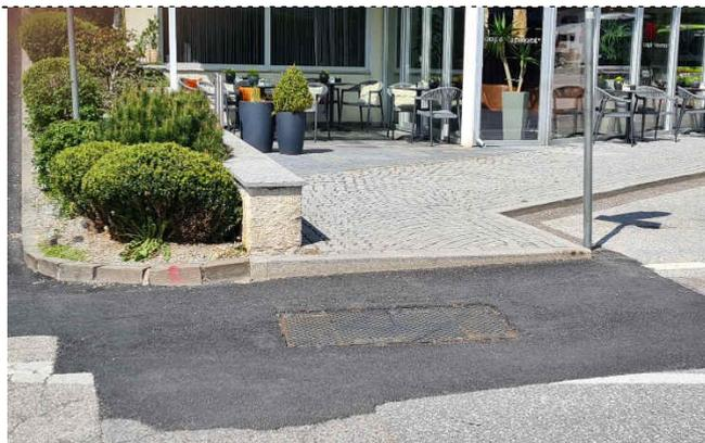
Gehsteig muss abgesenkt werden, um Barriere vom Randstein zu eliminieren (Rampe)
