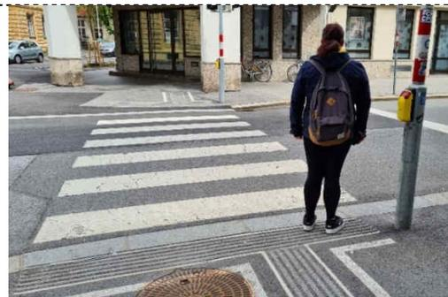
Die Bushaltestelle ist nicht Barrierefrei vom Rundgang aus erreichbar: Unregelmässiger Boden und Bodenbelagswechsel erschweren den Zugang. Ausserdem fehlt die Bordsteinerhöhung, um autonom und barrierefrei in den Bus mit Rampe einsteigen zu können.
