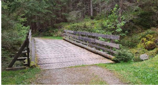
Die bestehende Brücke muss saniert werden, um die Unebenheiten und die grosse Fugen zu eliminieren, bzw. den Rollstuhlfahrern und den älteren Menschen einen angenehmen Übergang zu garantieren.
